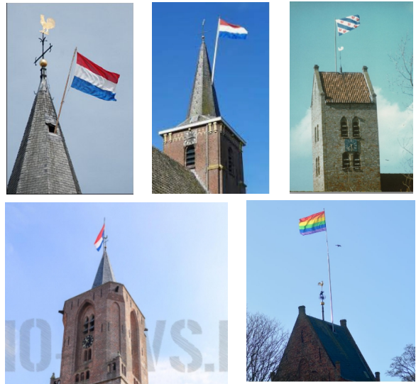
Enkele andere voorbeelden van doorgestoken masten
